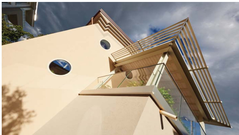
Casa Monica - edificio certificato GBC HOME
