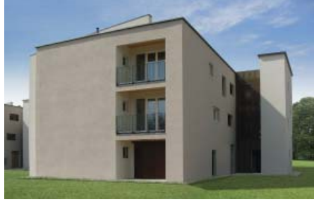
Edificio Cogefrin - Lugo di Ravenna (RA) GBC HOME ARGENTO - Punteggio: 50/110
