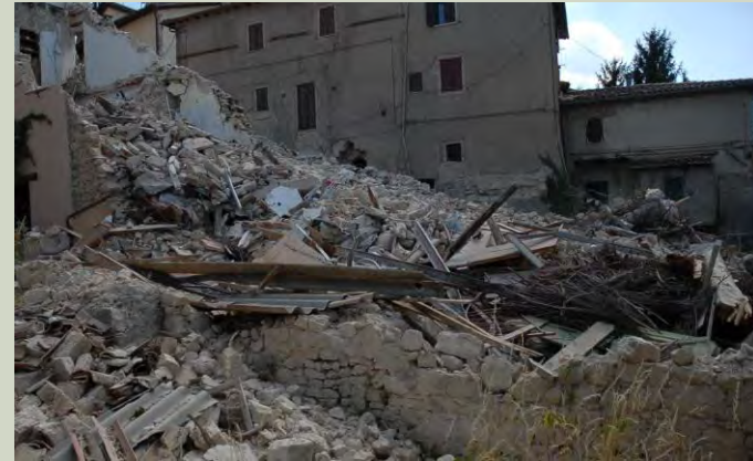
Amianto a matrice compatta
