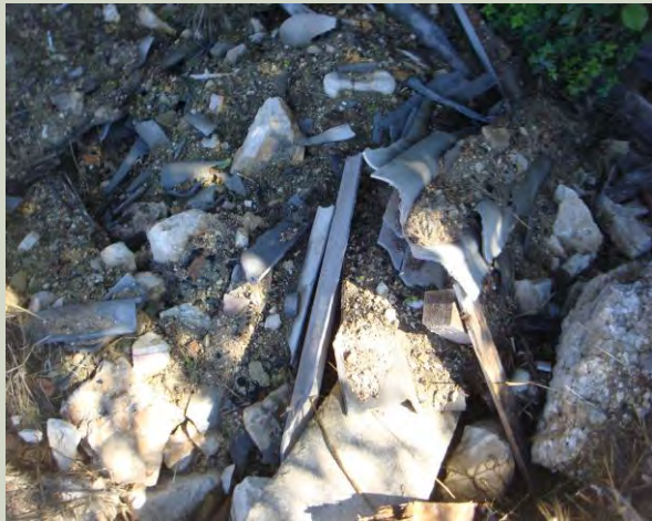
Amianto a matrice compatta
