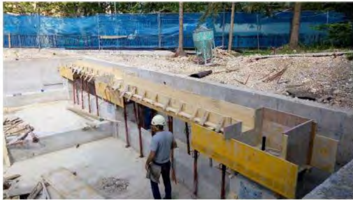
POSIZIONAMENTO ISOLATORI SISMICI
