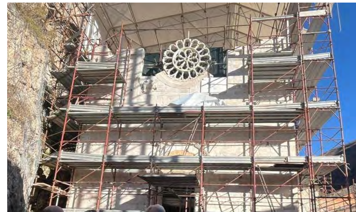
Nel corso dei lavori di ricostruzione
