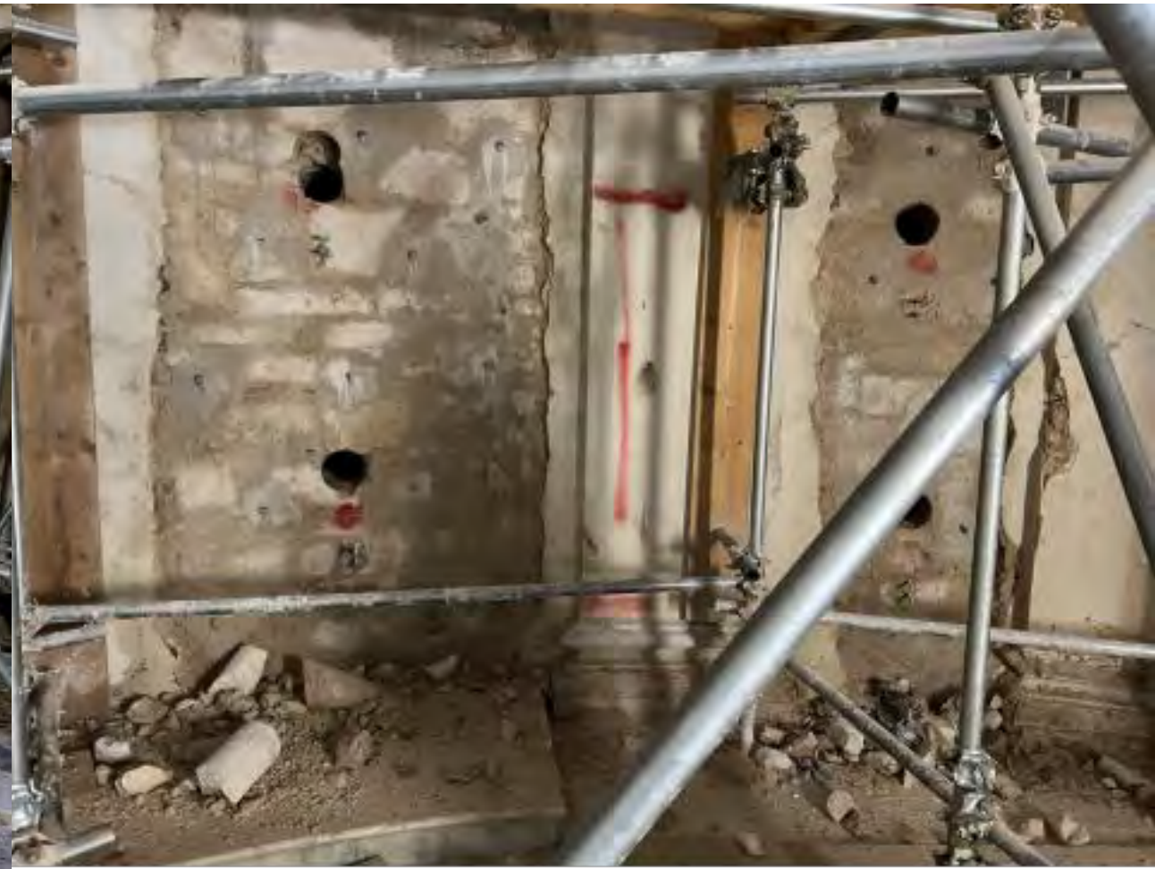
La realizzazione dei fori per l'alloggiamento dei diatoni in controfacciata
