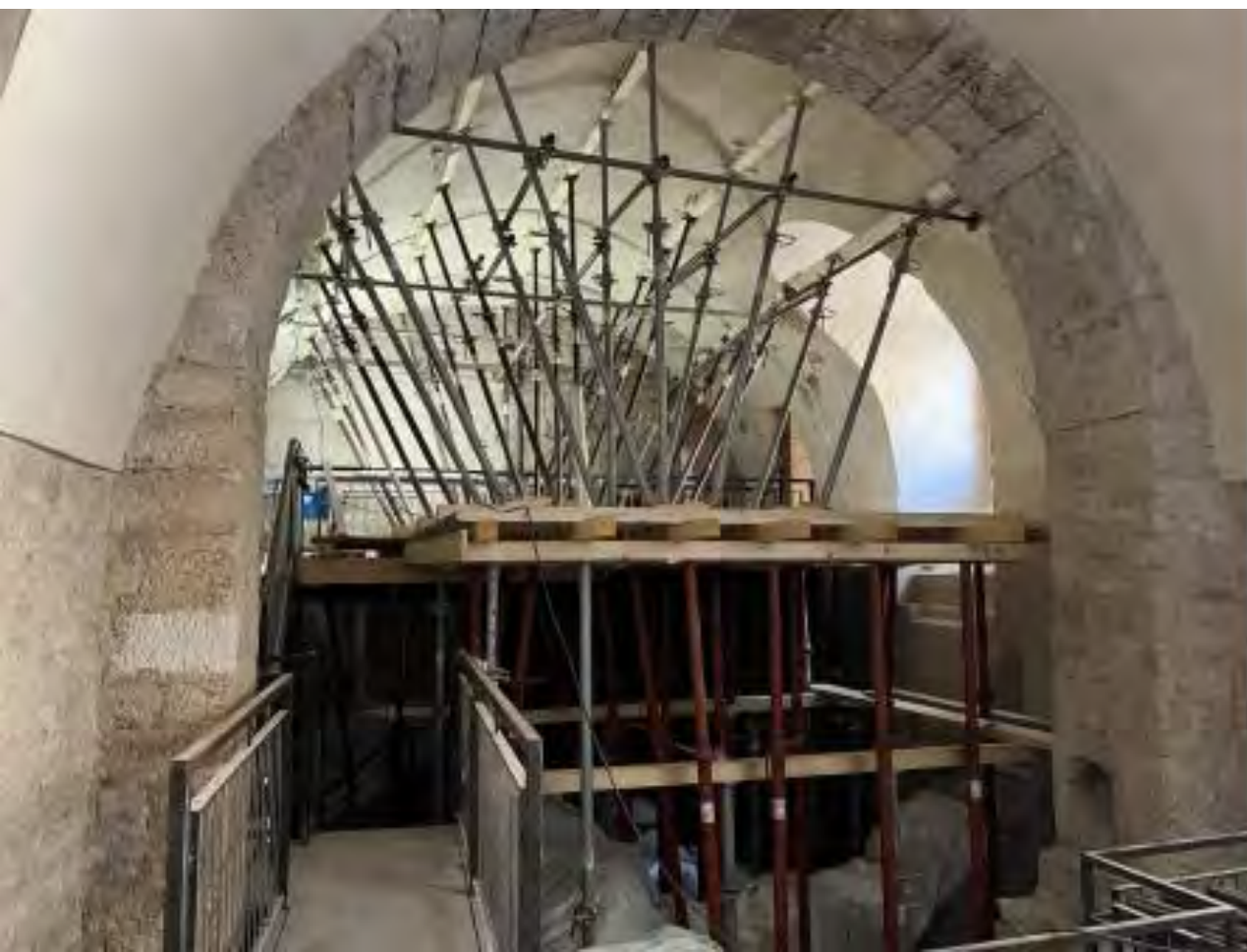
Le opere provvisorie di puntellatura sul lato del convento
