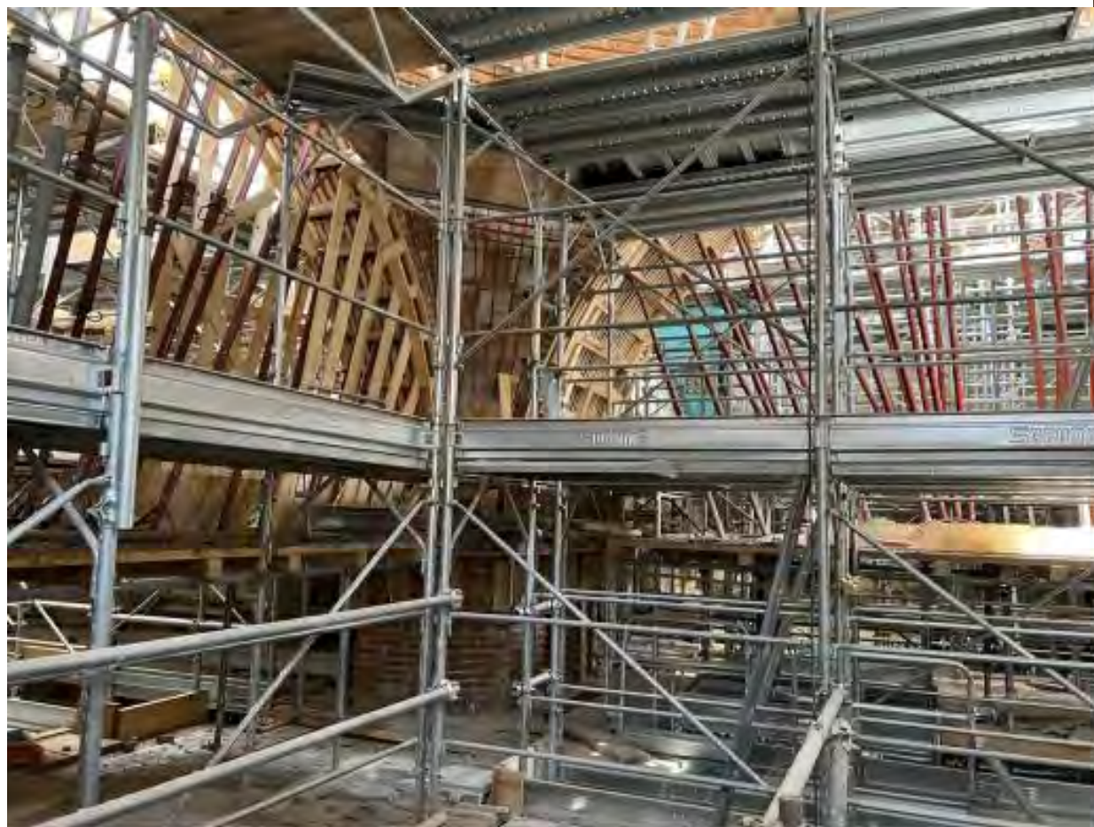
Le centine per la ricostruzione dei pennacchi e degli archi del transetto
