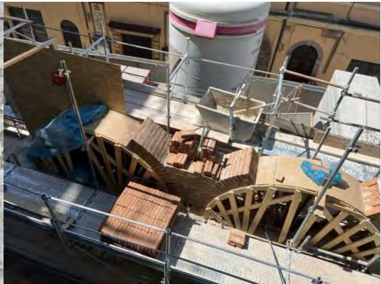
La ricostruzione degli archi del portico delle misure
