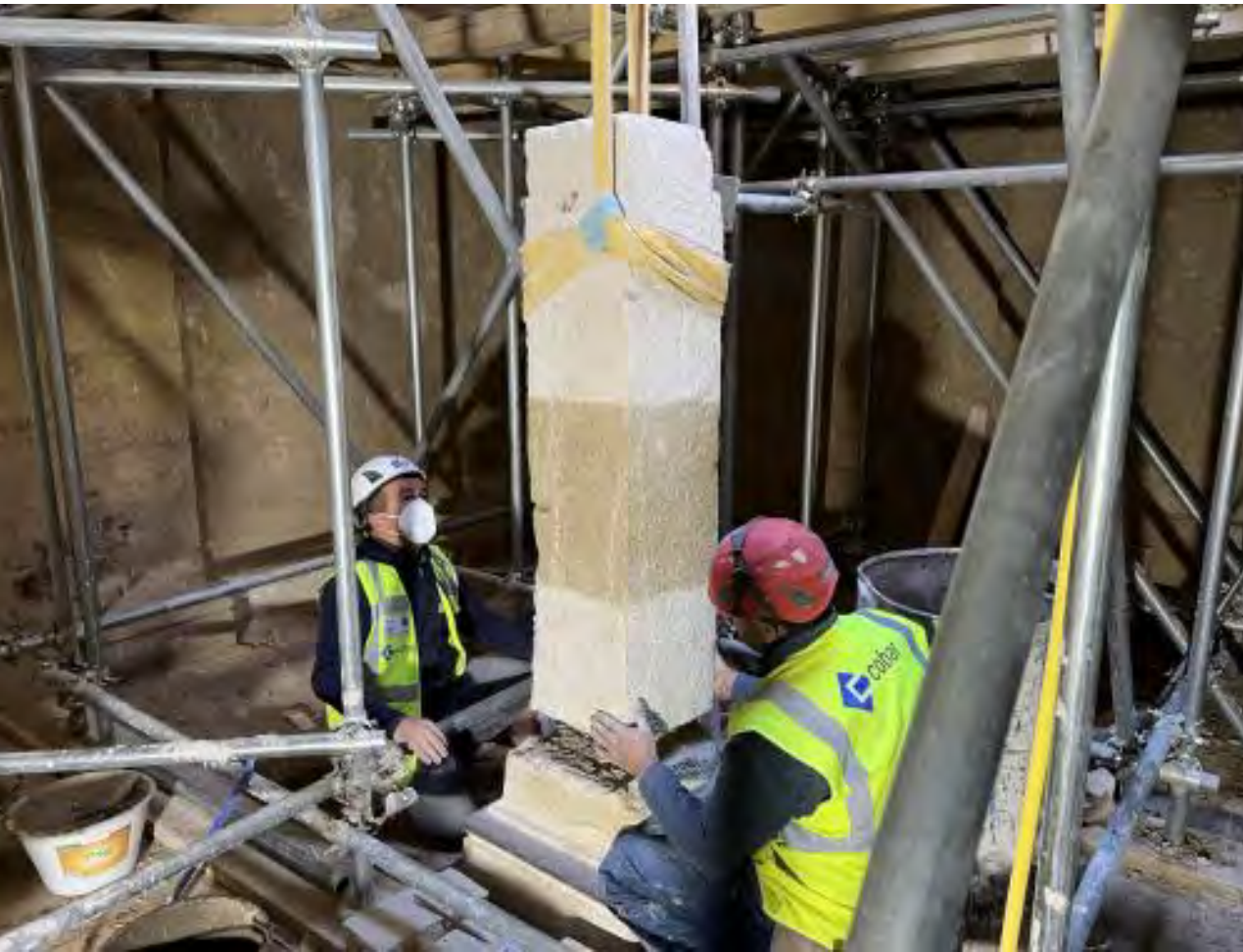
La ricollocazione in situ delle colonne della cripta
