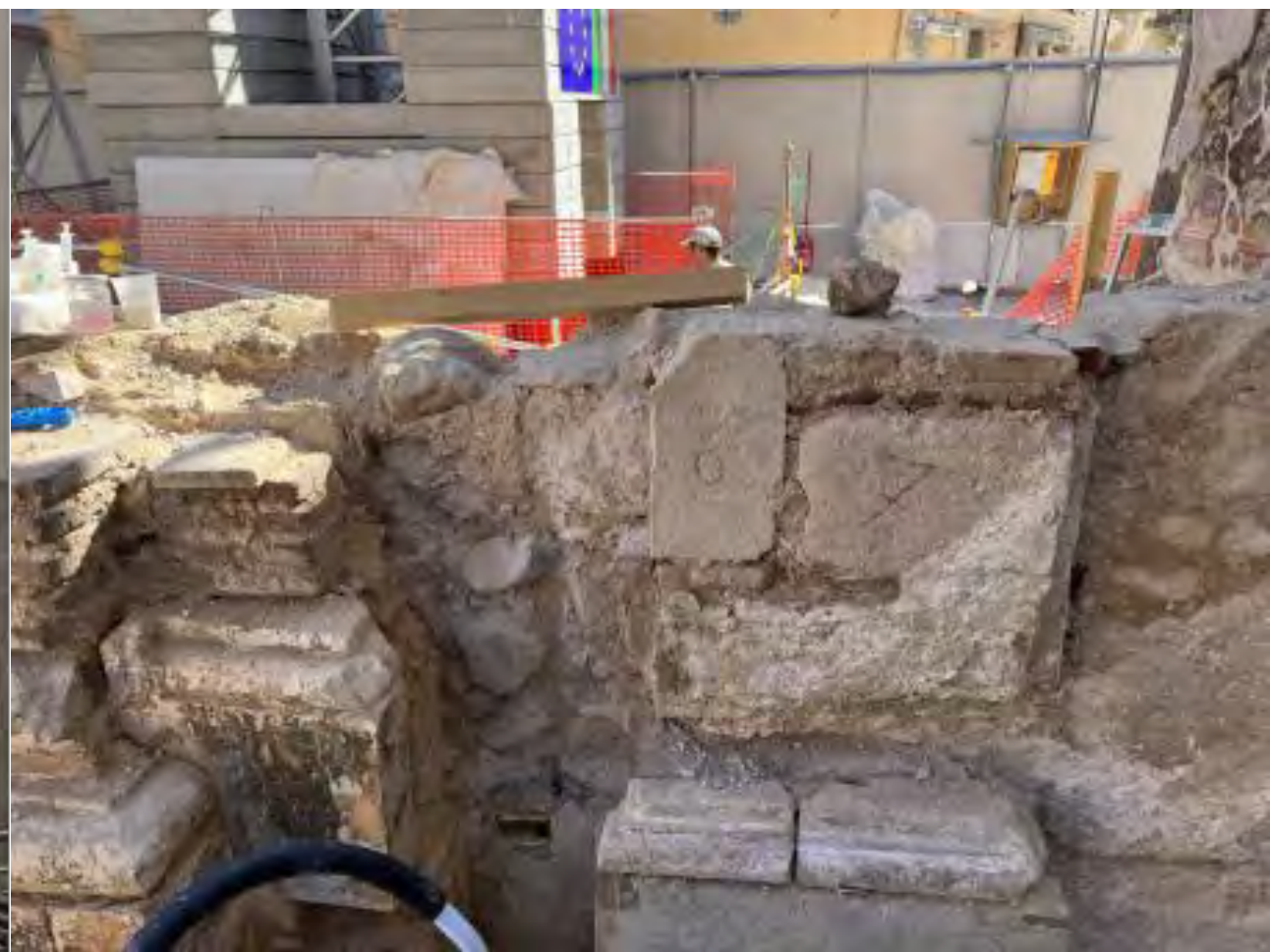
La catalogazione delle pietre per essere smontate
