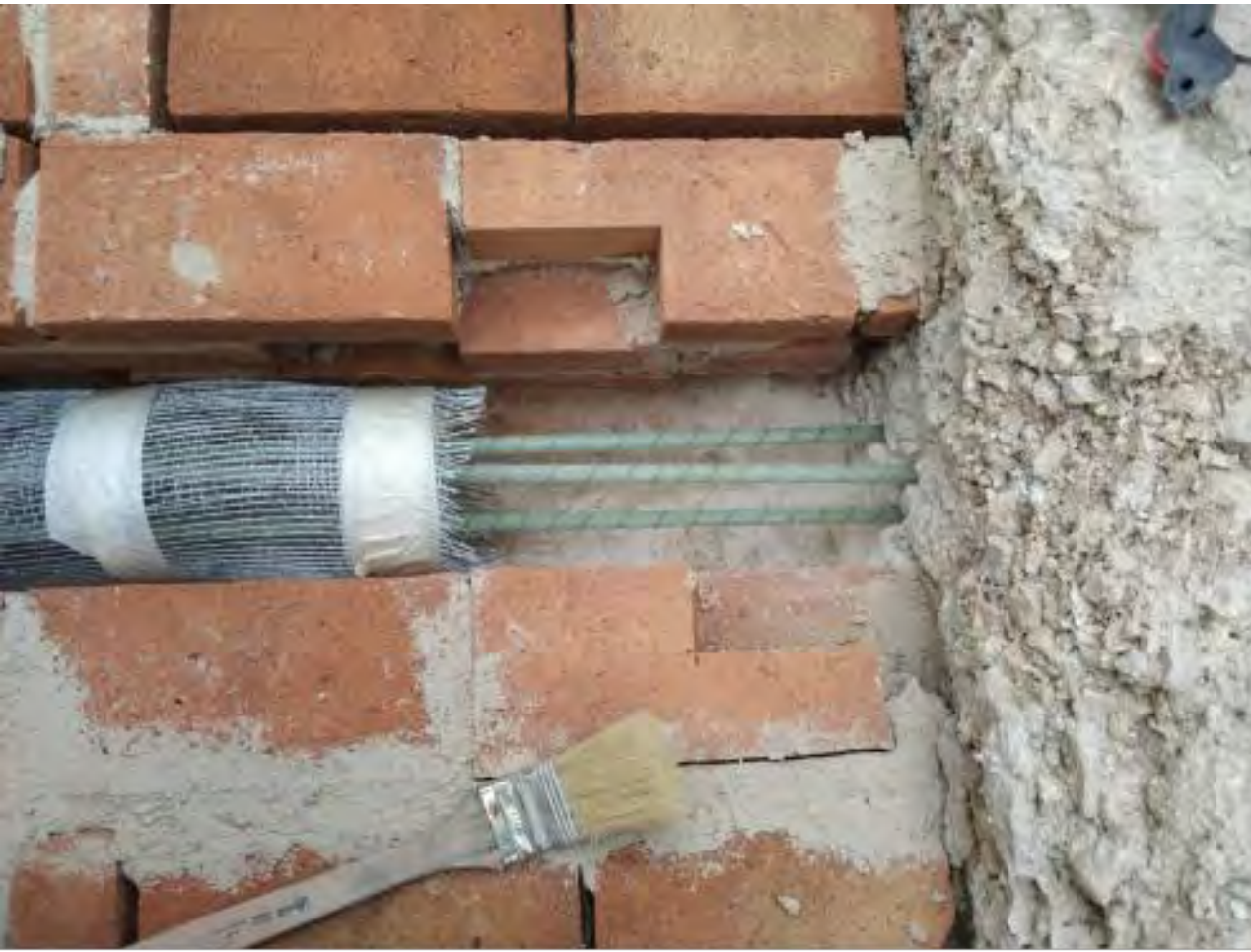
I diatoni di connessione e l'armatura in barre di fibra di vetro
