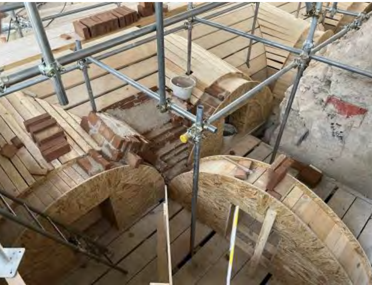
Le centine in legno per la ricostruzione delle volte della cripta
