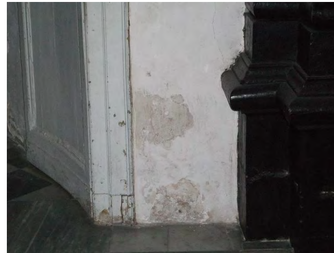
Situazioni diffuse di degrado da risalita capillare sulle murature
