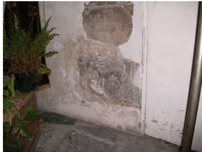
Situazioni diffuse di degrado da risalita capillare sulle murature
