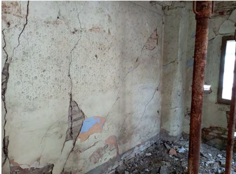
Puntellatura degli interni
