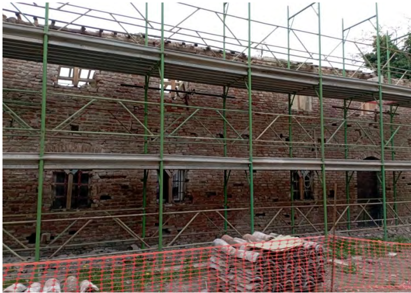
Ponteggio per operazioni in copertura
