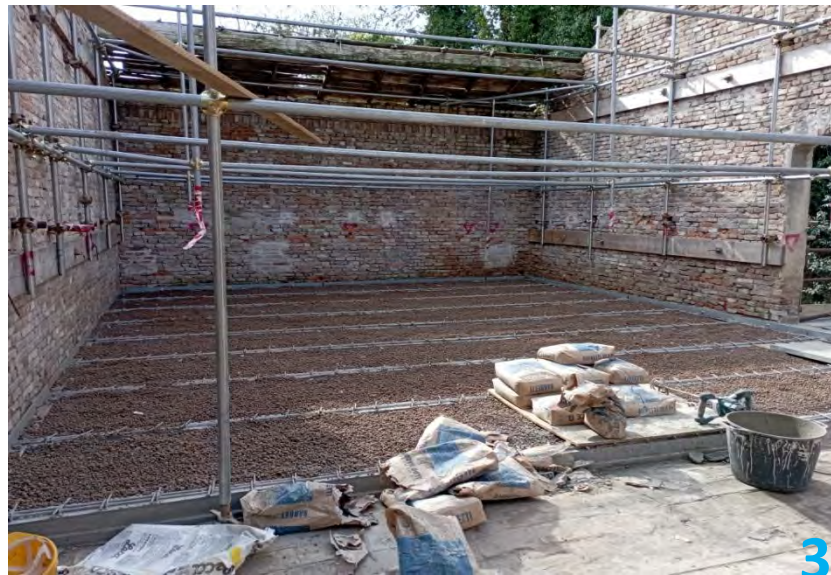
Formazione dei travetti in cls, posizionamento del cordolo in acciaio e riempimento delle voltine con argilla espansa
