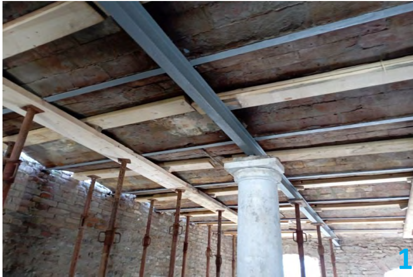
Puntellatura del solaio, pulizia di travi e voltine e verniciatura
