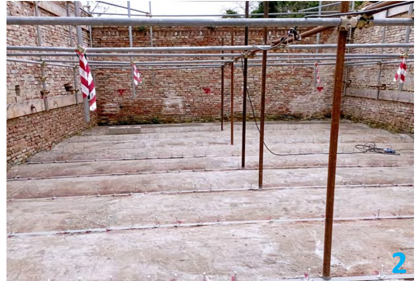
Piolatura con connettori metallici CTF a mezzo di chiodatrice a sparo
