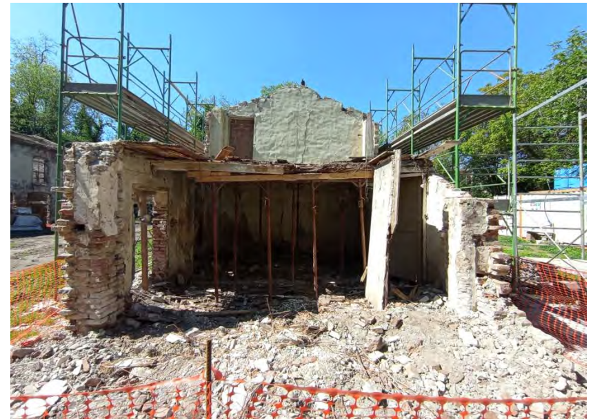
Smantellamento dell'orditura del solaio e delle porzioni di muratura non recuperabile
