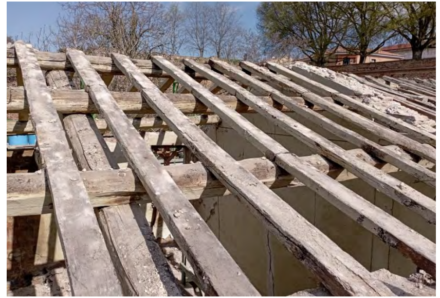
Smantellamento del manto di copertura
