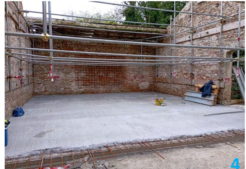
Posizionamento della rete elettrosaldata e getto della soletta in cls
