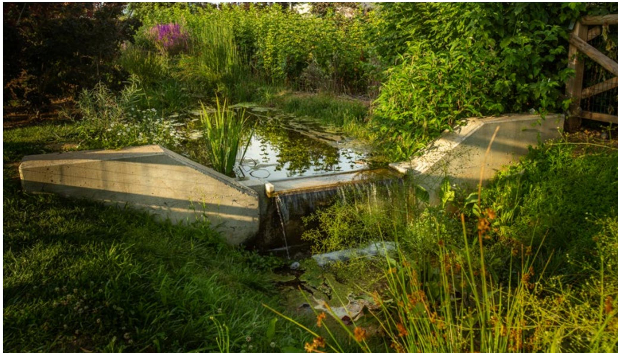
Il canale percorre per più di un chilometro il parco e lungo il percorso si trovano 11 stramazzi che consentono di ossigenare l'acqua e assecondare le pendenze del terreno.
