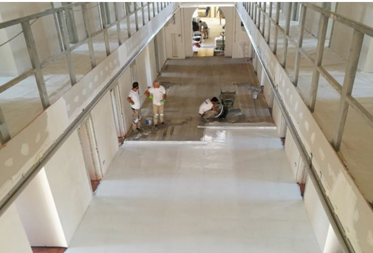
10,11. Posa della pavimentazione in resina a bassa emissione di COV componenti organici volatili su sistema radiante a terra su elementi in cotto.
